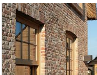
Buitenschrijnwerk (ramen en deuren)
